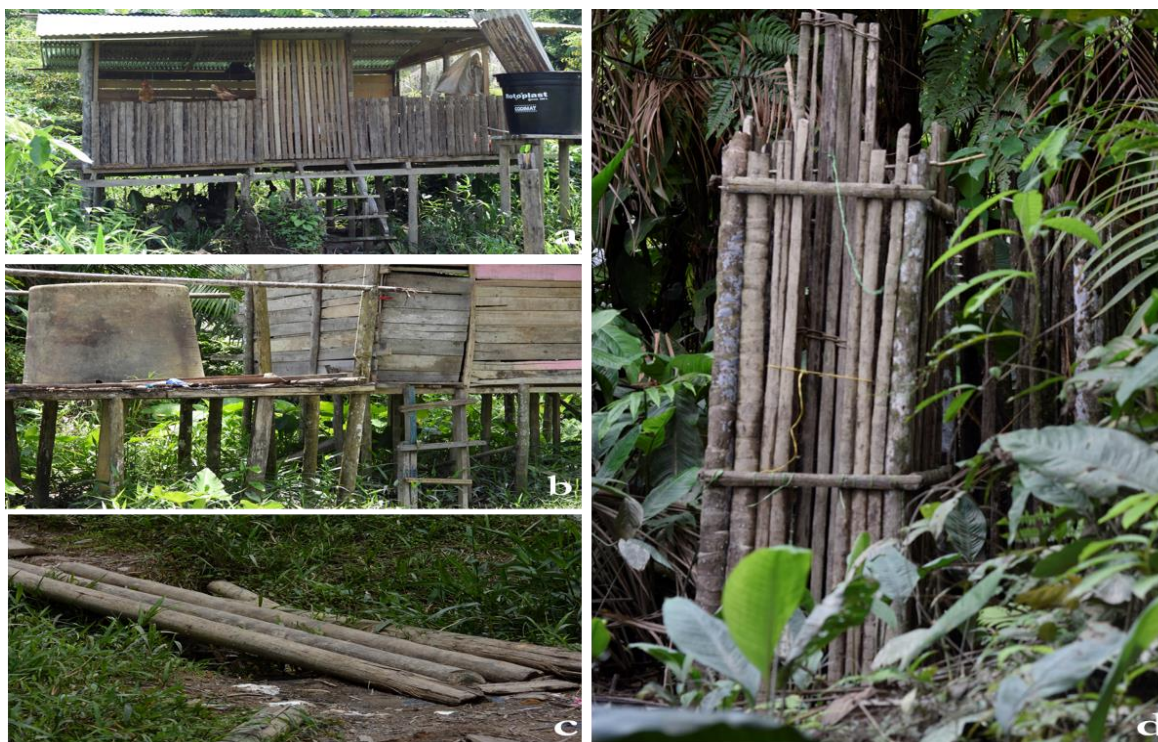
Figura 14. Algunos usos dado a la palma de Naidí en los del río Atrato y Quito: a) galpón; b) paleadera; c) puentes; d) corrales para la captura de peces.
