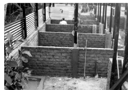
Vista lateral zoocriadero en construcción
