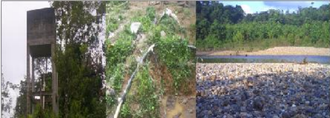
Imagen 4. Acueducto por bombeo y gravedad en las zonas de estudio.
